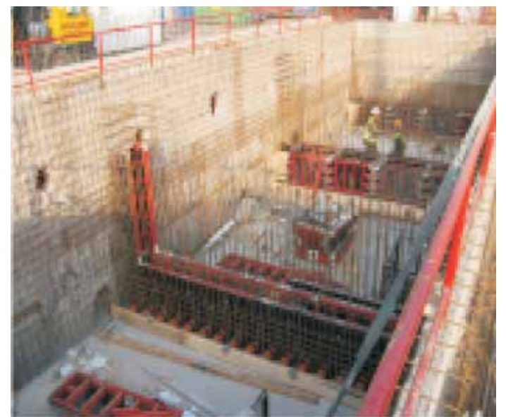
Písková filtrace - výztuž
