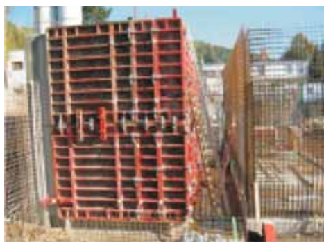
Montáž výztuže flotačních nádrží
