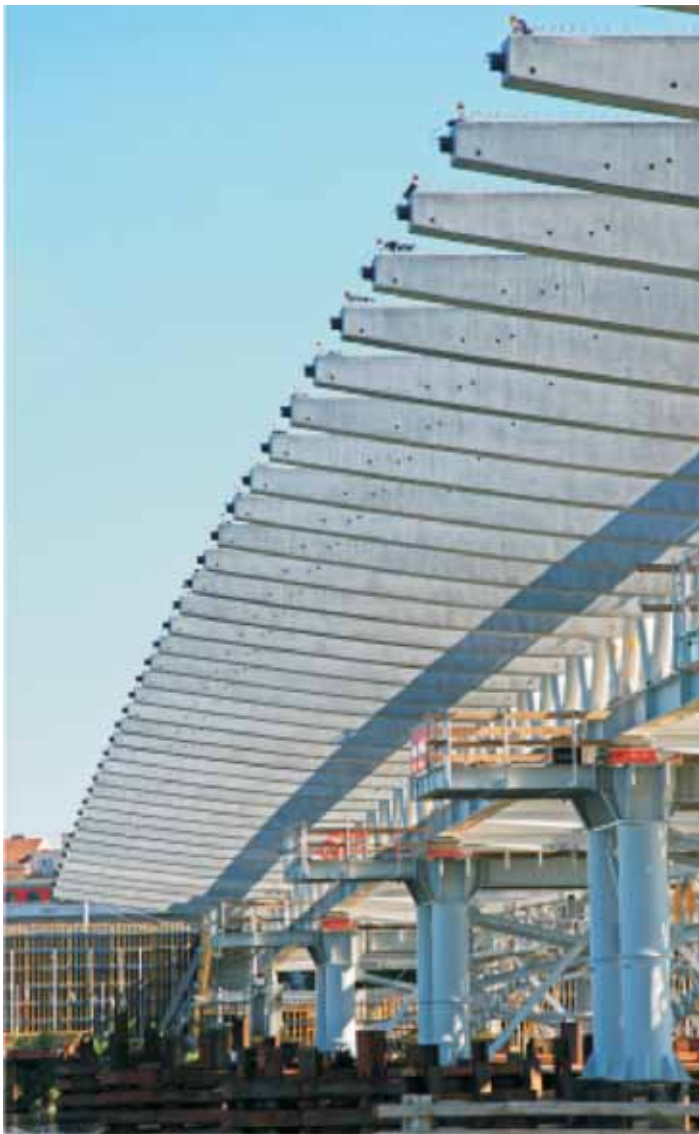
Trojský most, předepnuté příčnický
