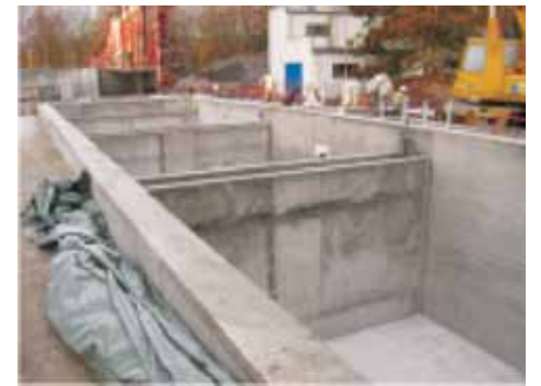
Hrubé betony pískové filtrace
