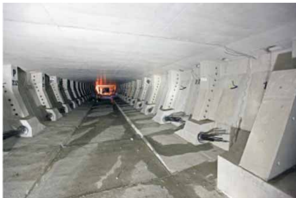
Vnitřek segmentového mostu - předpínání
