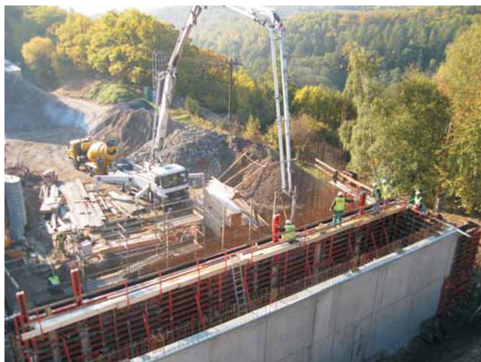
Betonáž flotačních nádrží
