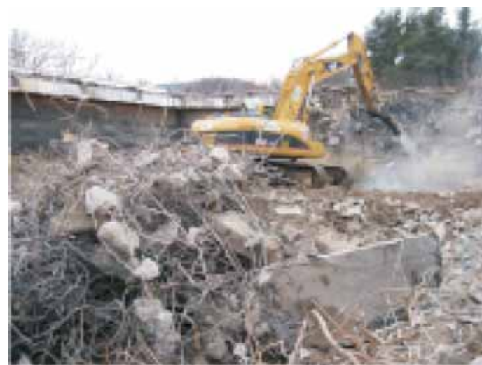
Demolice staré akumulace
