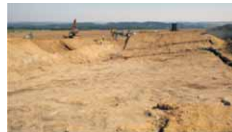
Odstraňování kontaminované zeminy hráze skládky po vrstvách na základě výsledků analýz
