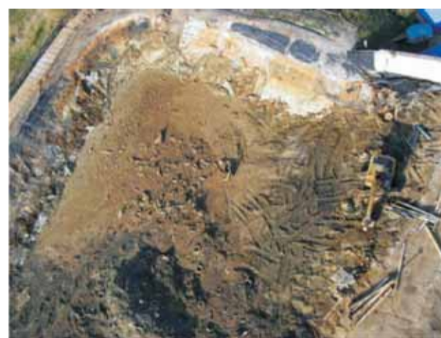
Celkový pohled na prostor skládkového tělesa před dokončením (pohled z jeřábu)
