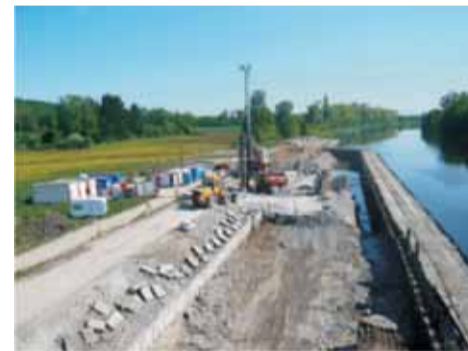
Štěťová jímka – horní voda
