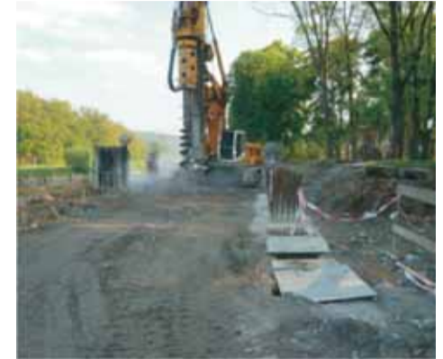
Převrtávané piloty dolní rejdy
