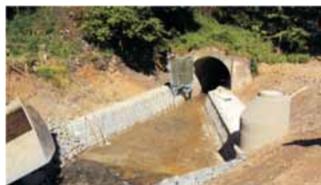
Kanalizace Švédský vrch – vstup do mostního objektu
