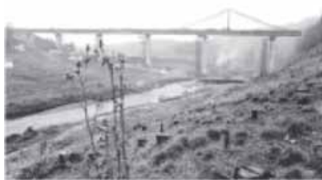
Most přes vodní nádrž u Římovu – dokončení 1979
