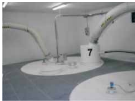
Rekonstrukce vápenného hospodářství, ÚV Želivka
