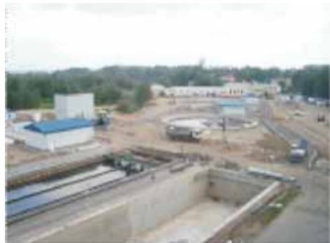
ČOV Cheb – pohled na část biologických linek v rekonstrukci, nově vybudovaná linka v pozadí
