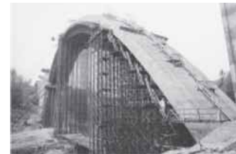
Výstavba obloukového mostu přes Ohři v Lokti – dokončení 1975
