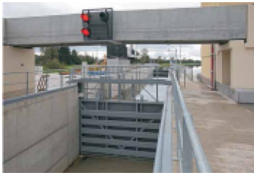
Plavební komora Hluboká
